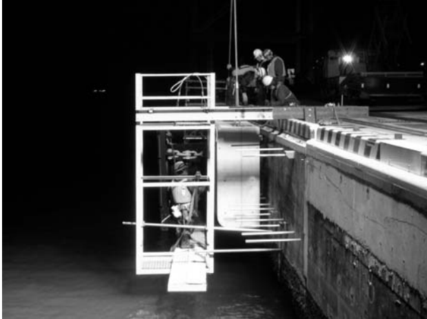
図-9 張り出しコンクリート（プレキャスト） 設置作業状況
