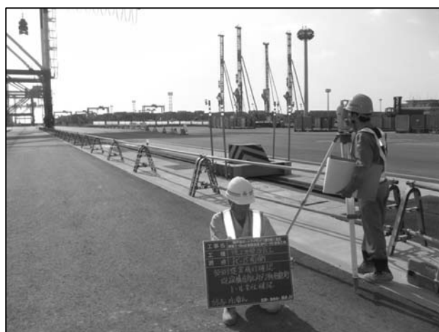
図-3 トータルステーションを用いたクレーンレール変位観測
