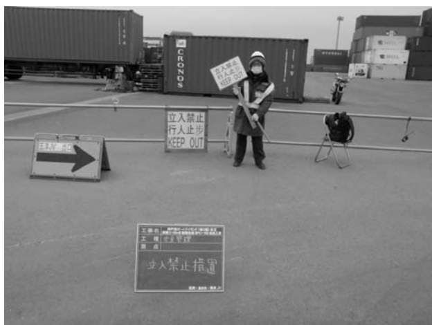
図-5 ガードマンおよび看板配置状況
