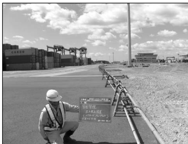
図-7 A型バリケード設置状況
