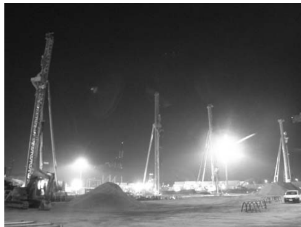
図-8 SCP夜間作業状況
