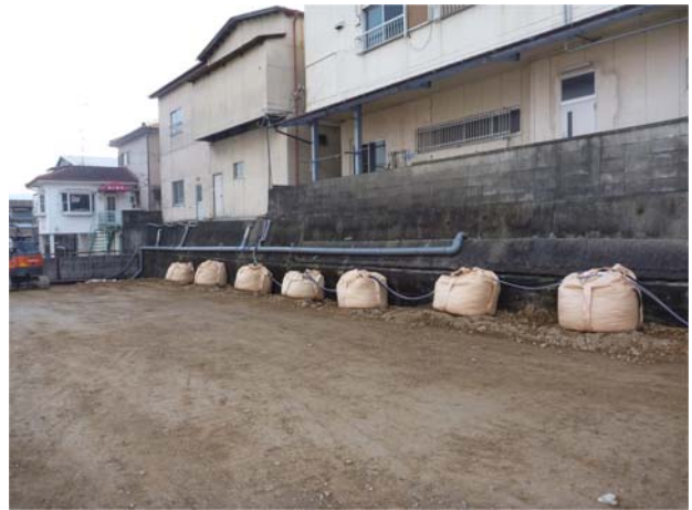
写真-5 大型土のう設置状況
