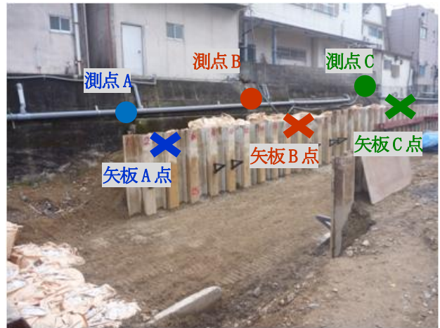
写真-4 施工中の調査測点
