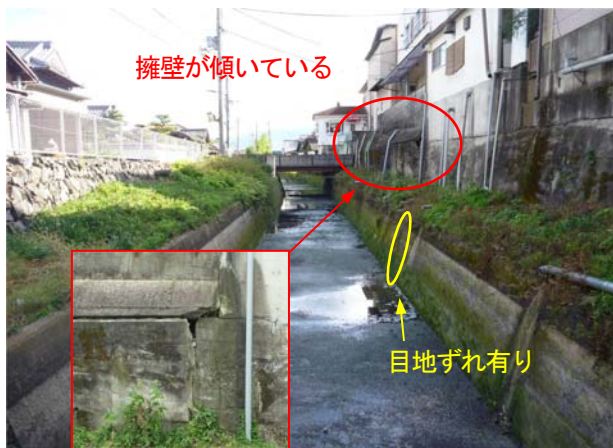
写真-1 施工区間全景(下流より)
