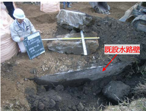
写真-2 試掘調査で確認されたコンクリート殻
