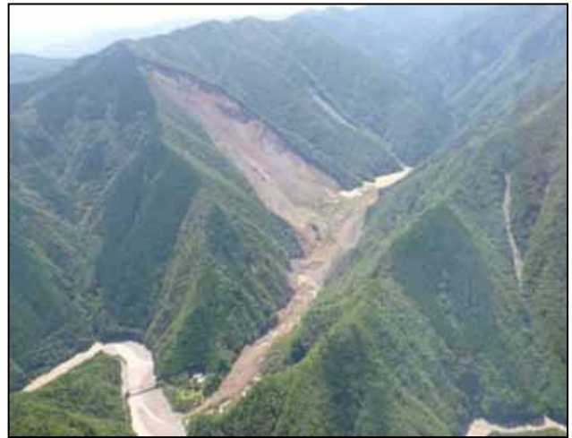
図-2 河道閉塞箇所(赤谷地区)
