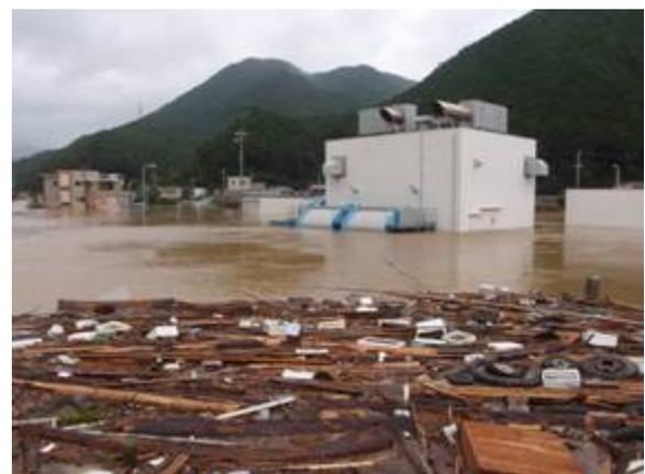
写真 2 水没した鮎田水門のポンプ場
