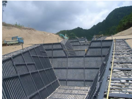
《仮排水路（吹付けモルタル）》
