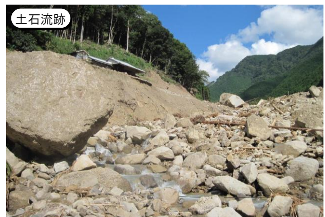
写真-1 熊野地区で発生した災害
