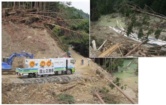
《STEP①-2：下池からの水替え（筏式フロート排水ポンプ）》
