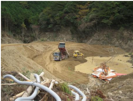
《STEP③：応急排水路の構築（鋼製枠）》
