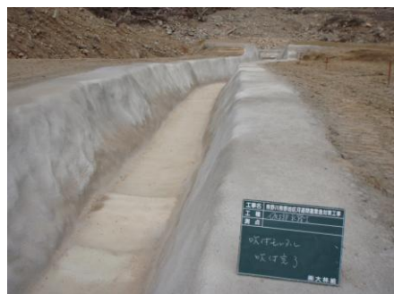
写真-2 施工状況
