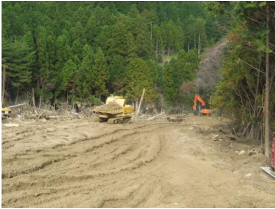
写真-3 上池埋戻し状況
