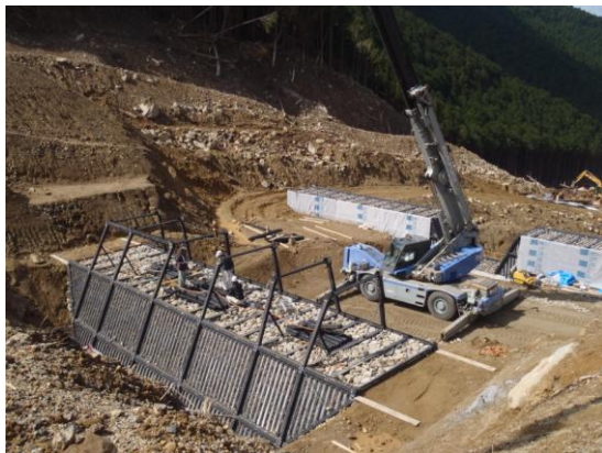
写真-5 鋼製枠組立状況
