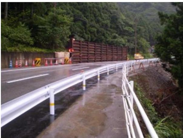
図-9 仮設防護柵設置状況
