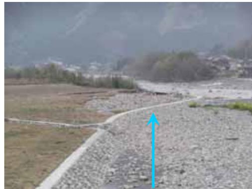
写真-4 低水護岸突出部が洗掘された状況
