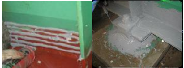
(写真-8) シリコンシーリング施工
