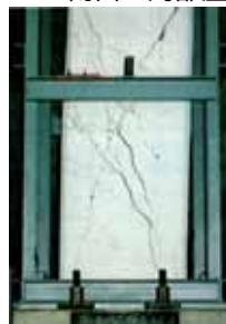
図-9 RC橋脚下部の西面のX型亀裂 15) と南面の局部座屈鉄筋の露出(P460橋脚) 13)
