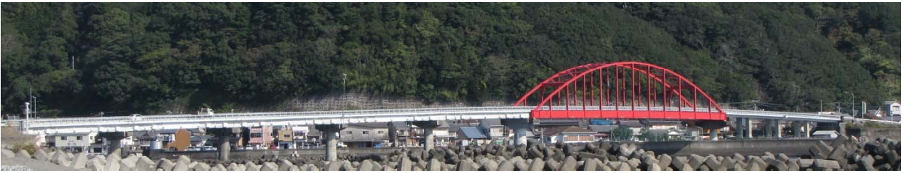
写真-2 古座大橋全景（串本側海岸より）
