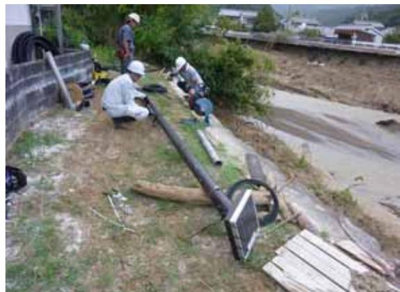
図-9 水位観測設備の応急復旧作業(那智川)
