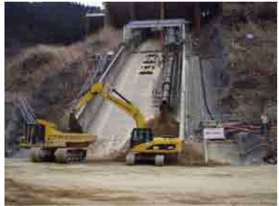
写真-7 CSG積込状況
