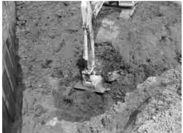
図-8 試掘による障害物除去
