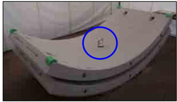
写真-2 吊金物取付状況
