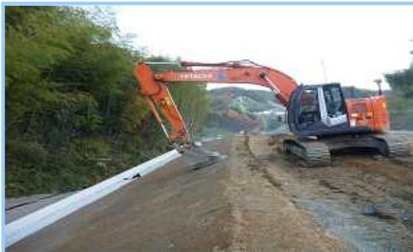
図-10 丁張りが無い中でのバックホウによる道路土工施工
