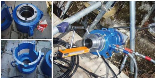
写真6 油圧ジャッキの取り付け
