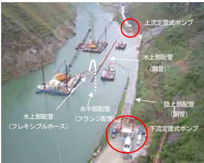
写真-3 打設状況(2台同時施工時)
