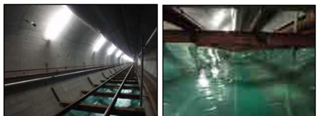
写真-7 インバートシート養生状況
