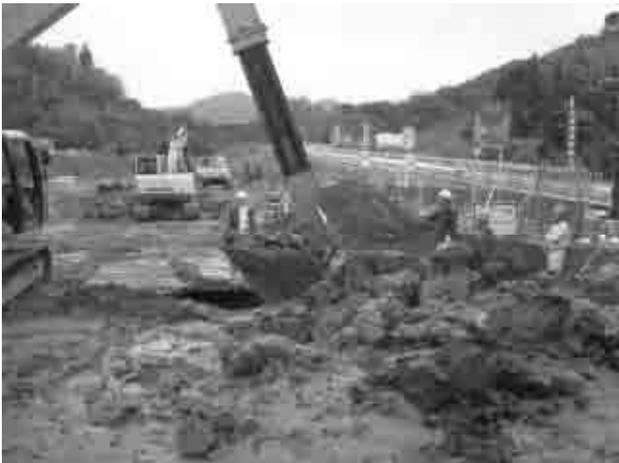
図-6 玉石の除去作業状況
