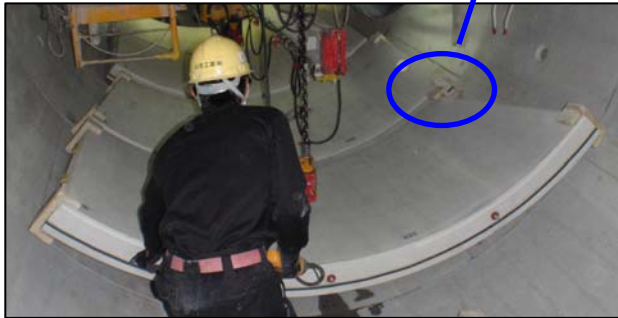
写真-1 R Cセグメント搬送状況
