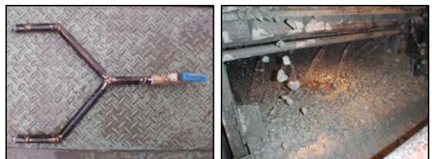
写真-6 高粘性粘土付着防止措置実施状況
