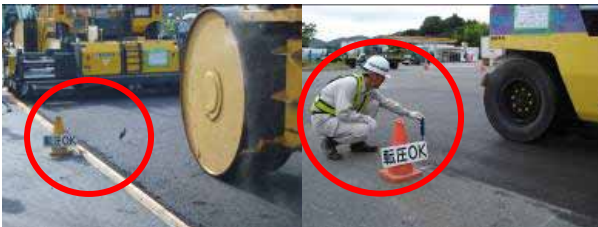
写真-5 初期転圧温度測定
