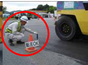
写真-6 2次転圧温度測定
