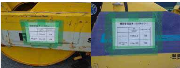
写真-7 ロードローラ回数明示
