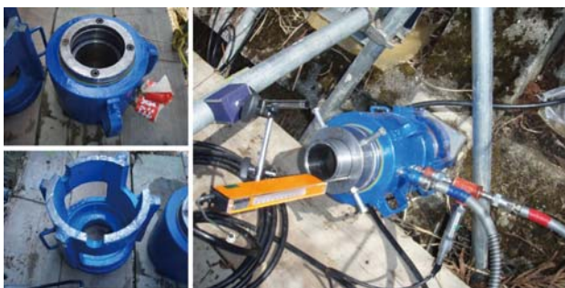
写真6 油圧ジャッキの取り付け
