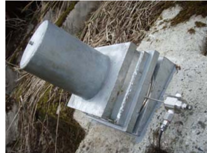
写真-1 荷重計設置状況
