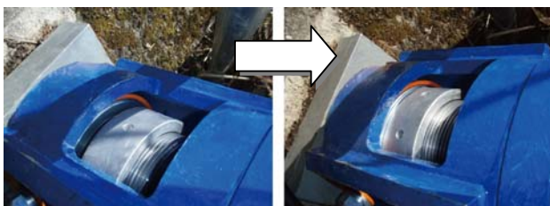
写真7 リフトオフ確認後の定着ナットの締め付け
