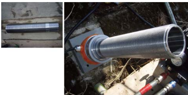
写真5 テンションロッドの設置
