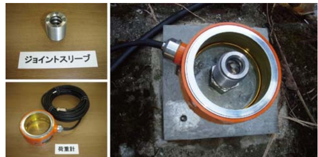
写真-2 ジョイントスリーブ・荷重計の設置
