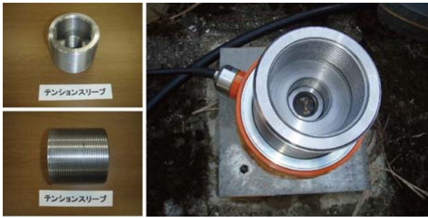
写真3 テンションスリーブの設置
