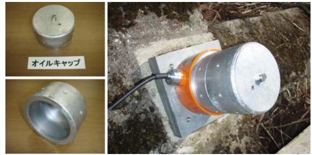
写真8 オイルキャップの設置
