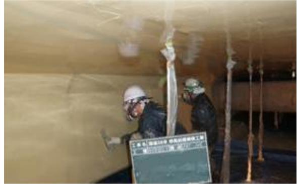
写真-2 左官工によるタフガードQ-R工法施工
