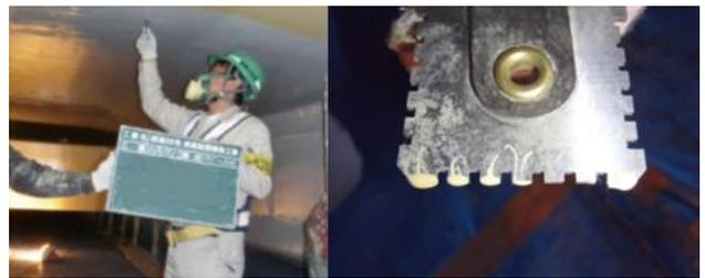
写真-3 ウェットゲージによる膜厚管理
