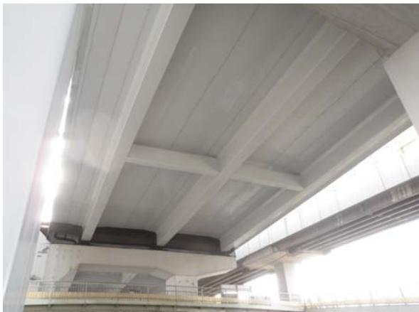
写真-1 タフガードQ-R工法施工後（堺高架橋）
