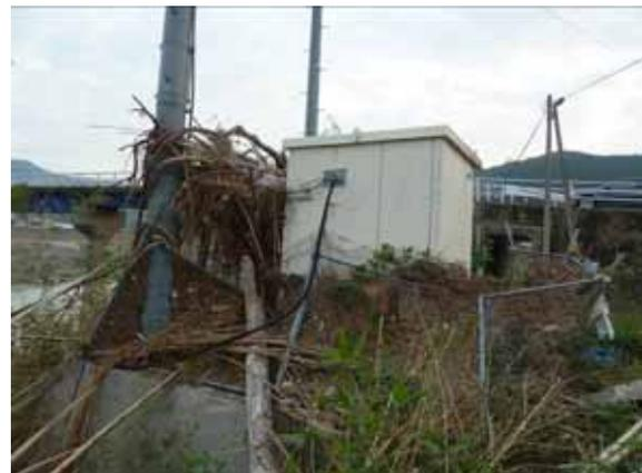
図-8 洪水により被災した水位観測所(日高川)
