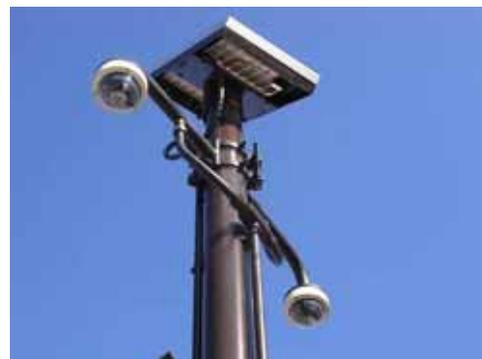
図-5 上下流撮影用のカメラ(ドームタイプ)
