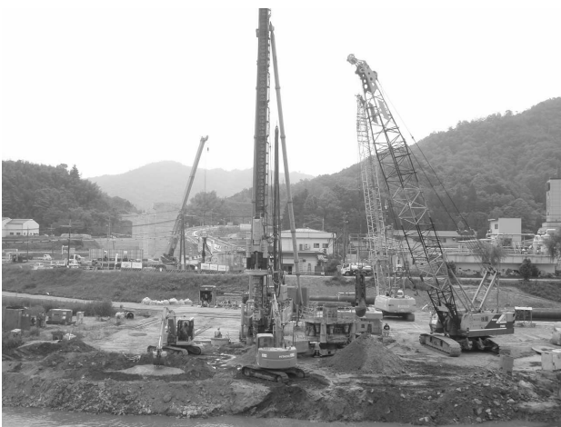
図-4 鋼管ソイルセメント杭の施工状況
