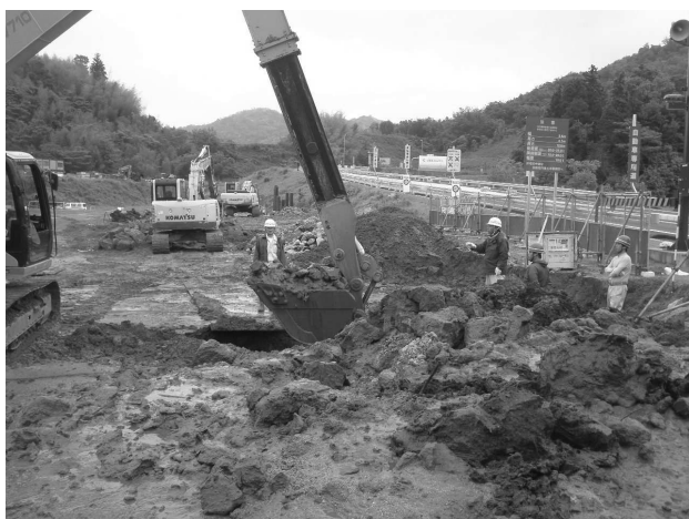
図-6 玉石の除去作業状況
