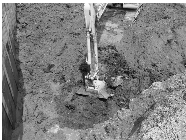
図-8 試掘による障害物除去
