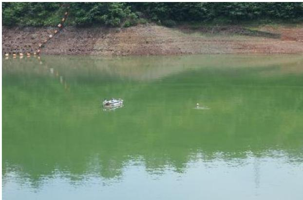
複合型曝気装置運転（浅層循環機能のみ停止）
