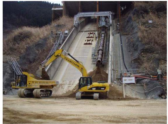
写真-7 CSG積込状況
