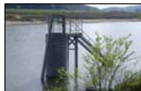
写真 3-① コルゲート管式 （高水位対策型）
