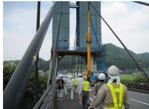
写真3 府発注工事の現場視察（国道173号新綾部大橋）
