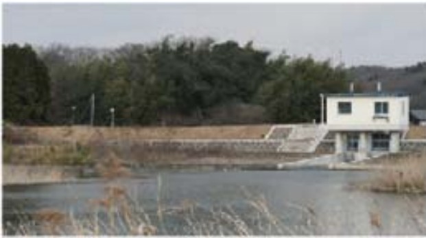
写真-1 伊賀市水道の取水口(木津川)
