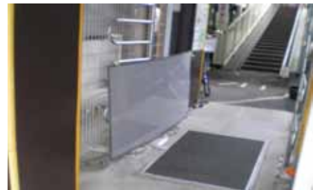
写真-4 電波吸収体 (写真中央)
