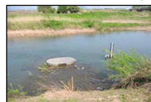
写真 3-③ コルゲート管式 （堆積物防止型）
