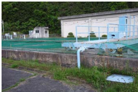
守田浄水場 (H22.5.17撮影)
