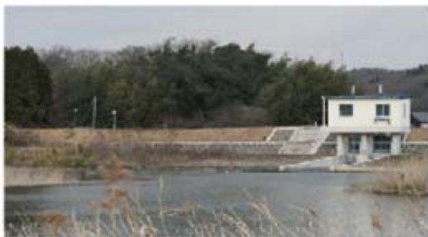
写真-1 伊賀市水道の取水口(木津川)
