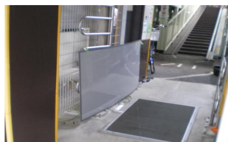
写真-4 電波吸収体 (写真中央)
