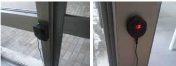
図-12 物産館と情報館の入口に設置した人感センサー
