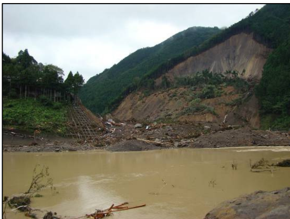
図-1 宇井地区の土砂流出
