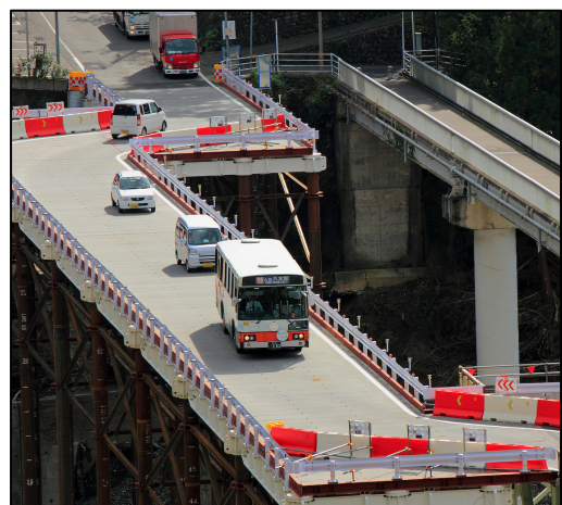
図-5 応急復旧した折立橋を渡る八木新宮線
