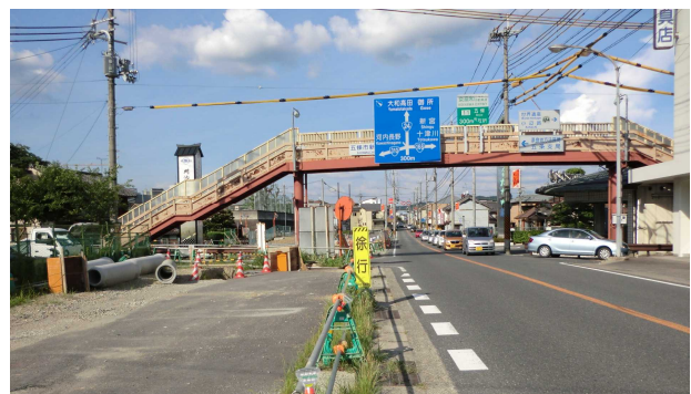
写真-3 既設横断歩道橋
