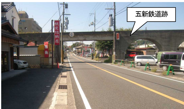
写真-2 国道24号を跨ぐ五新鉄道跡
