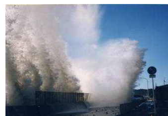
台風による越波状況(西向付近)
