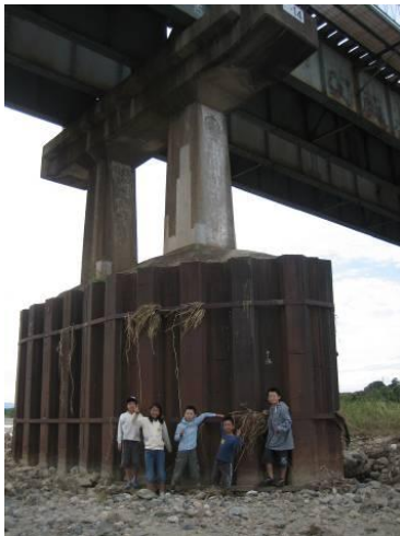
写真2 現在の近鉄木津川鉄橋の橋脚部
