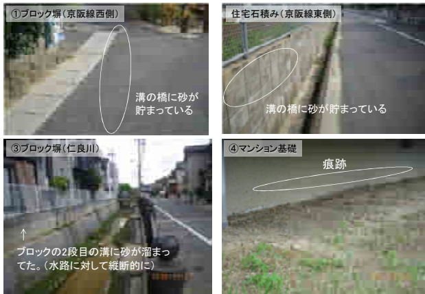
図-6 洪水痕跡の確認（現地踏査）
