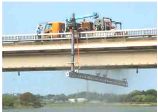
写真-2 三国大橋における橋梁洗浄の状況
