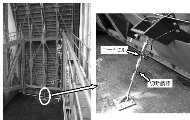
写真-2 鋼棒切断加振法の装置設置状況
