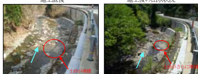
写真-7 施工後の土砂堆積状況
