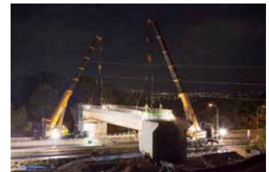
図-10 ランプ橋架設完了
