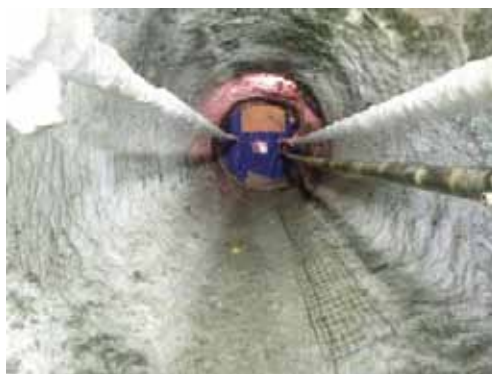
写真-3 横坑掘削完了
