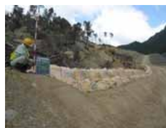
図-13 防護土堤の設置状況
