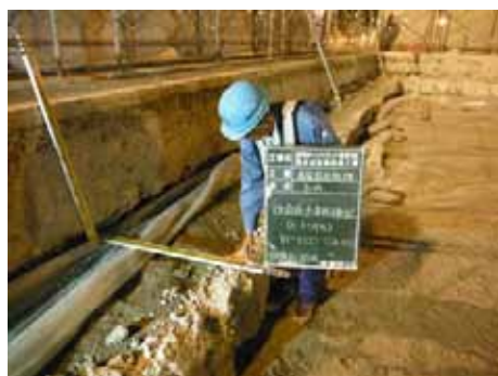
写真-6: コンテナ蔵置エリア 境界部 (施工完了)
