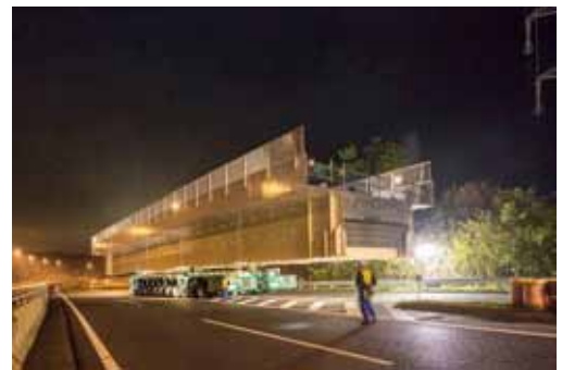
図-8 地組桁を載せた多軸台車
