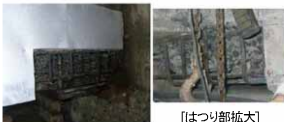
写真-6 はつり作業完了
