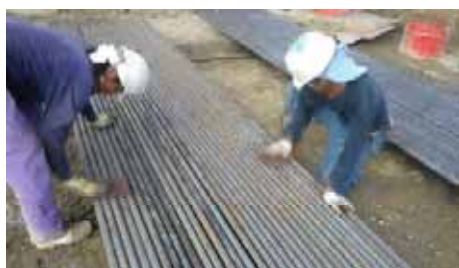
写真-10 有害物拭き取り状況
