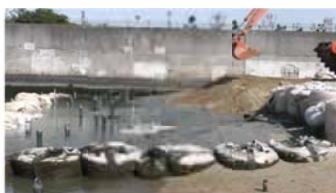
写真-3 改質土投入後の覆砂工
