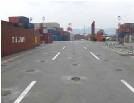
写真-9：車上プラント配置予定場所（日中）
