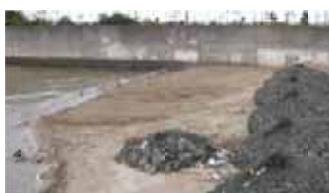
写真-4 覆砂工完了後
