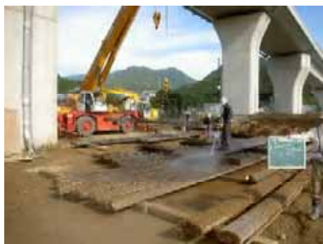
写真-9 鉄筋水洗い状況
