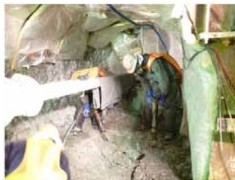
写真-2 横坑掘削状況
