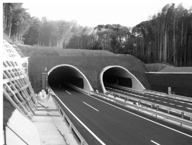
写真-1 起点側坑口全景
