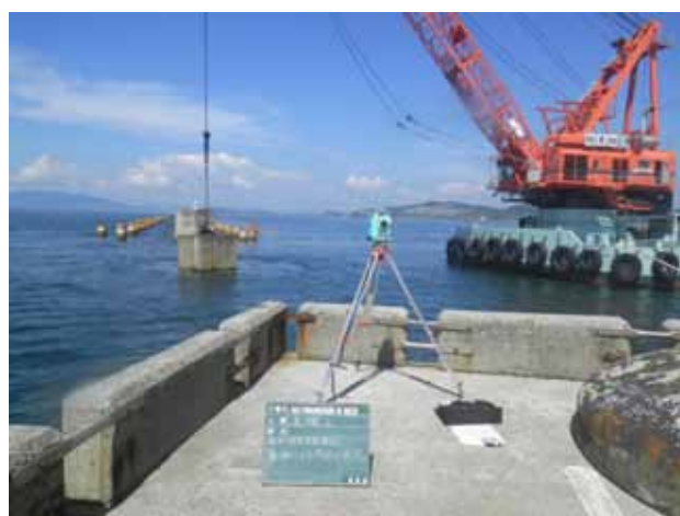
図-6 重錐による突き固め状況
