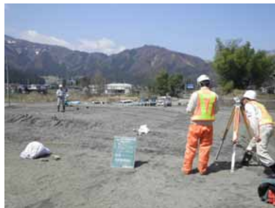
写真 6-1 基盤沈下量測定状況
