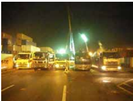
写真-10：車上プラント配置状況（夜間）
