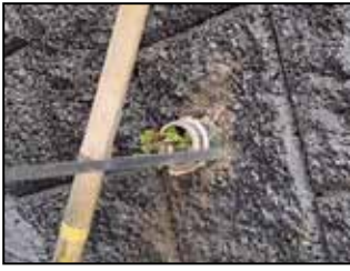
施工時の状況
