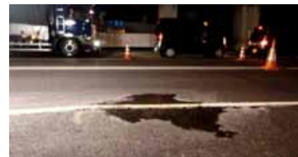
写真-3. 薬液の路面リーク状況
