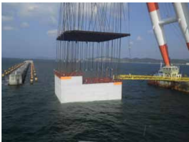
図-7 ケーソン据付状況
