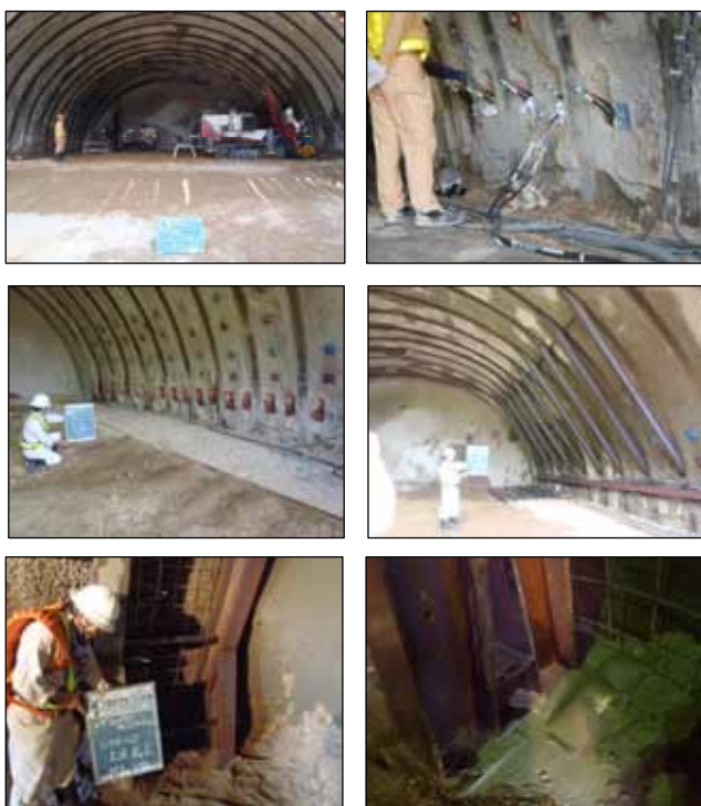
写-2 レッグパイル施工状況
