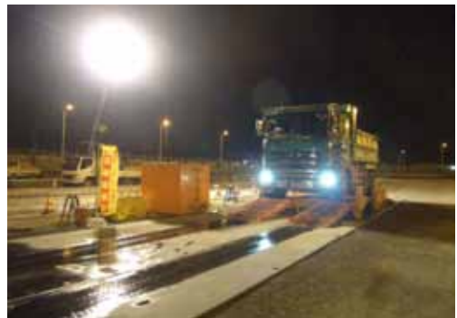
写真-12：タイヤの土砂洗浄状況
