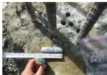
写真-12 小径コア採取状況(場所打ち杭天端)
