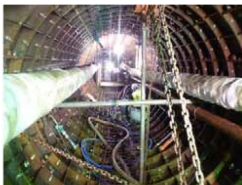
写真-3 セグメント組立状況
