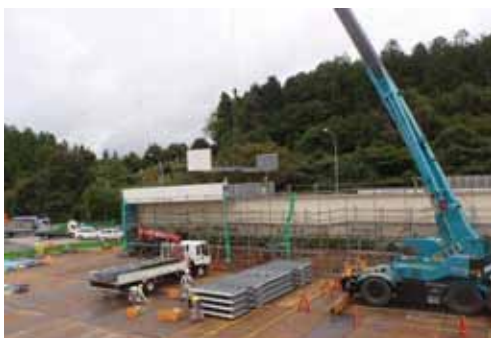
図-7 合成床版パネル設置状況
