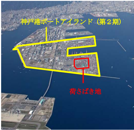
写真-3 神戸港PI（第2期）地区荷さばき地
