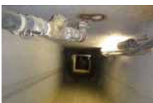
写真-2. 箱形ルーフ内のクレーショック充填状況
