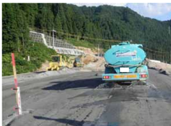
写真-7-1 散水状況
