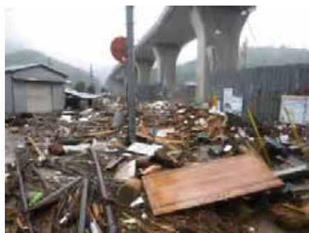
写真-2 現場周辺道路
