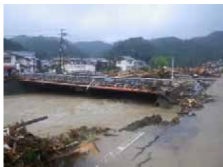
写真-1 川関橋損壊状況
