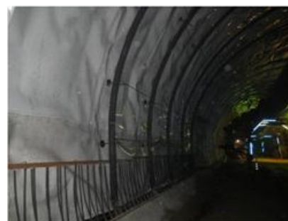
図-7 鉄筋支保工組立状況
