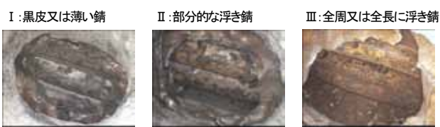
写真-5 PC鋼材腐食度 判定基準
