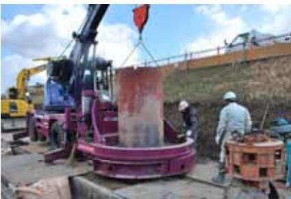
写真3 ケーシングの引き抜き (Step3)
