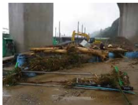
写真-5 現場保管鉄筋埋没状況
