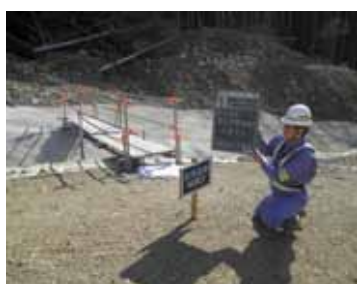
図-14 避難するために設けた仮排水路を横断仮橋
