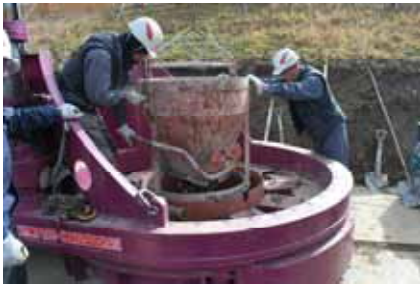
写真2 ドレーン材の充填 (Step2)
