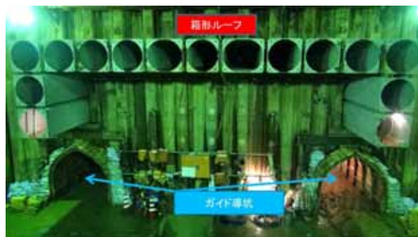
写真-1. ガイド導坑、箱形ルーフの設置状況
