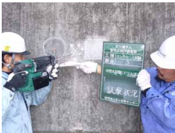
図-8 中性化試験（ドリル法）
