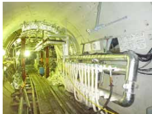
写真-1 凍土造成状況
