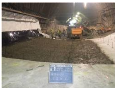
図-6 保護モルタル施工状況
