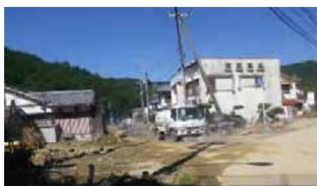
写真-7 散水車による道路清掃状況
