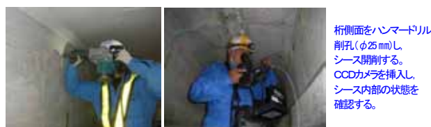
写真-4 削孔・CCD法 調査状況
