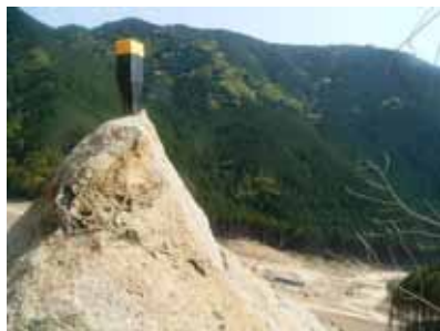
図-7 崩壊検知センサー設置状況
