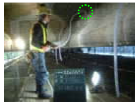
⑤〔圧力確認〕:注入ポンプ圧力計
