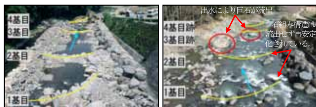
写真-5 落差工での石組み再安定化の状況(福岡県岩岳川) ②
