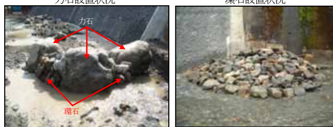
写真-6 施工状況
