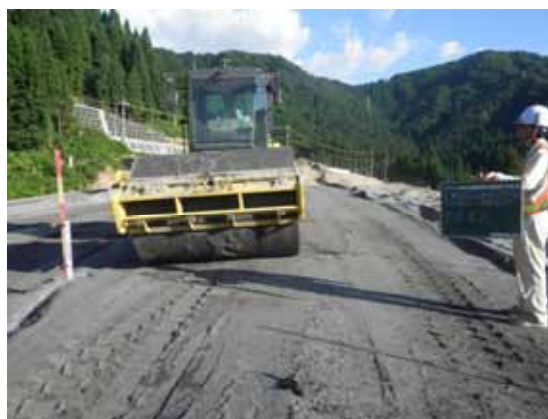
8. まとめ 写真-7-2 転圧状況
