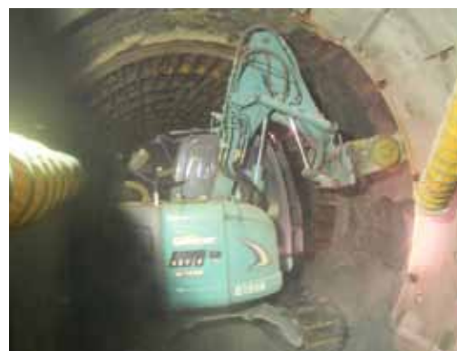
写真-3 ツインヘッダー掘削状況
