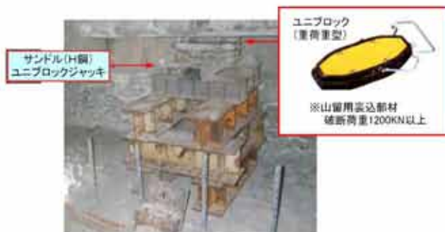
写真-3 二重の安全対策としての仮受け材設置状況
