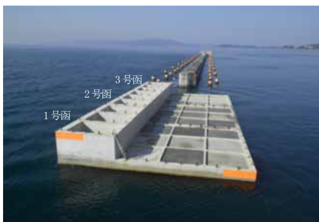
図-9 ケーソン据付後の状況
