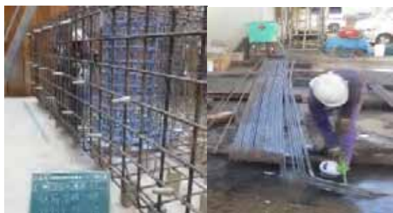
写真-11 錆転化型防錆材塗布状況
