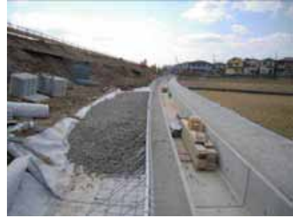
写真5 水平ドレーン工設置 (Step5)
