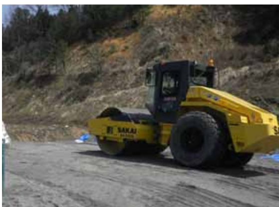
写真-6-3 転圧状況
