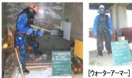
写真-5 はつり作業状況
