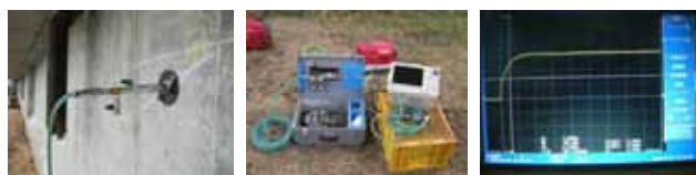
写真-7 空圧法 調査状況・機器および出力波形例
