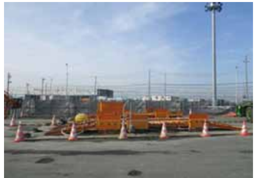
写真-11：タイヤの土砂洗浄機
