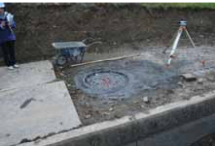
写真4 ウェルドレーン完成 (Step4)
