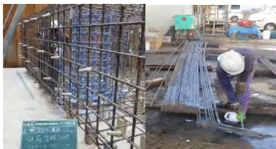
写真-11 錆転化型防錆材塗布状況
