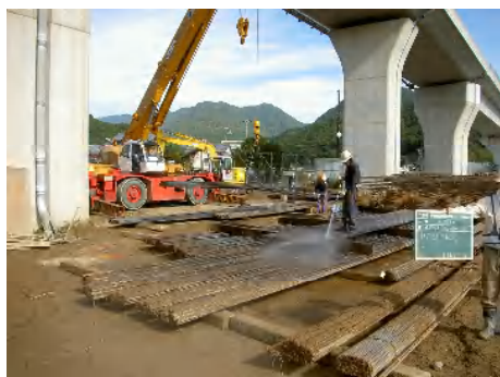
写真-9 鉄筋水洗い状況
