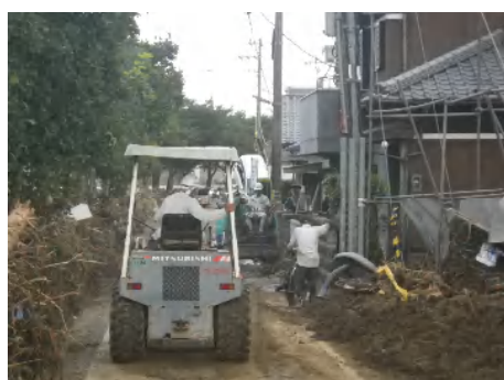
写真-6 被災直後の道路の復旧作業状況
