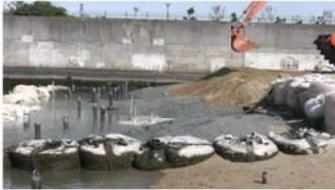
写真-3 改質土投入後の覆砂工
