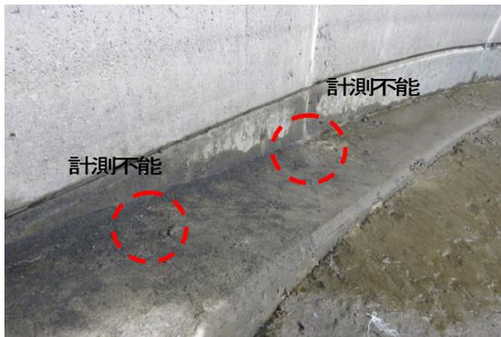
図-4 基礎排水孔の流失状況
