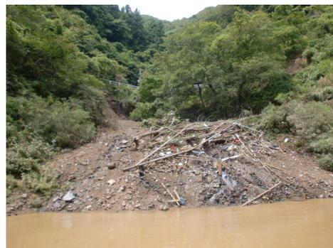
図-3 天ヶ瀬ダムの貯水池への土砂の流入状況(2012)
