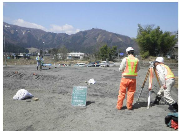
写真 6-1 基盤沈下量測定状況
