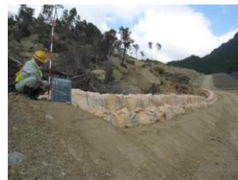
図-13 防護土堤の設置状況
