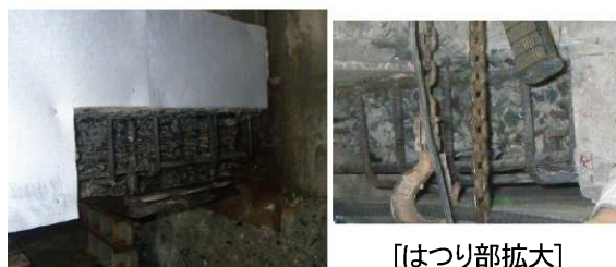
写真-6 はつり作業完了
