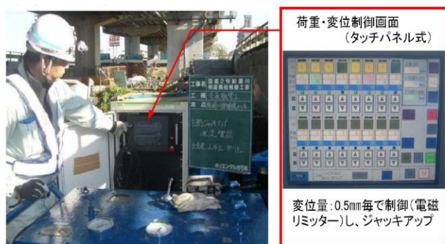
写真-1 ジャッキおよび変位計設置状況
