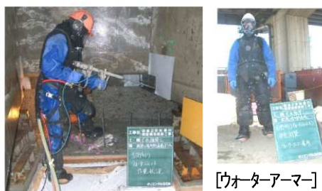
写真-5 はつり作業状況
