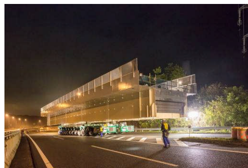
図-8 地組桁を載せた多軸台車
