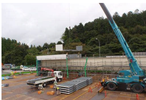
図-7 合成床版パネル設置状況
