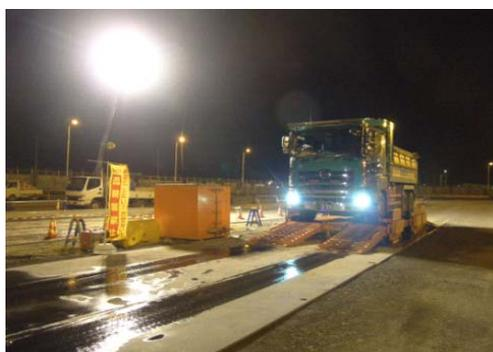
写真-12：タイヤの土砂洗浄状況
