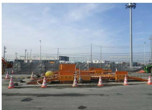
写真-11：タイヤの土砂洗浄機
