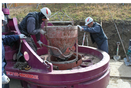
写真2 ドレーン材の充填 (Step2)
