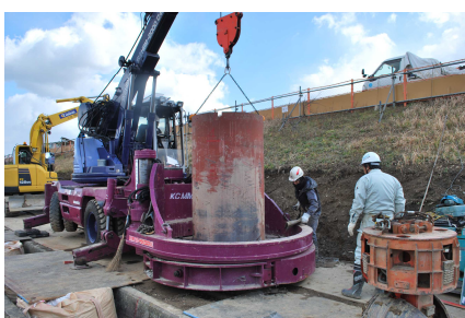
写真3 ケーシングの引き抜き (Step3)
