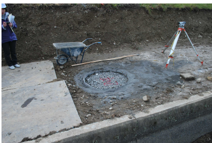
写真4 ウェルドレーン完成 (Step4)
