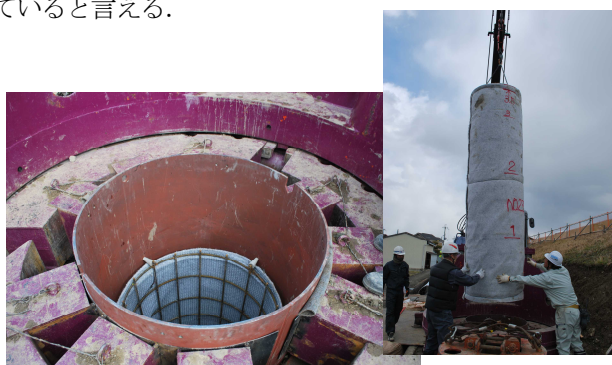
写真1 削孔および鉄筋カゴの据え付け (Step1)
