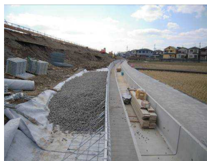
写真5 水平ドレーン工設置 (Step5)
