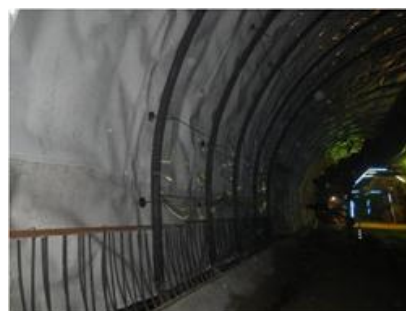
図-7 鉄筋支保工組立状況
