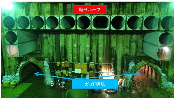
写真-1. ガイド導坑、箱形ルーフの設置状況
