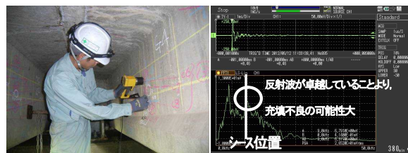
写真-3 IE法 調査状況・出力波形例
