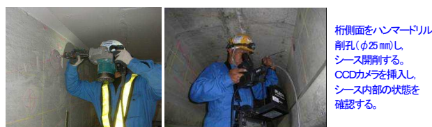
写真-4 削孔・CCD法 調査状況
