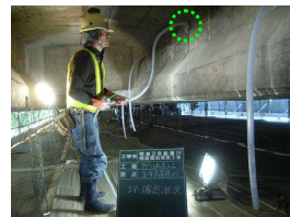
⑤〔圧力確認〕:注入ポンプ圧力計
