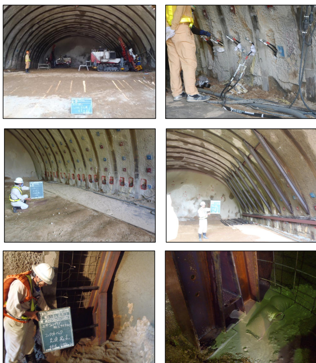
写-2 レッグパイル施工状況
