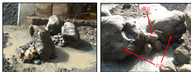
力石設置状況
