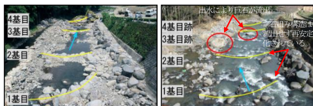
写真-5 落差工での石組み再安定化の状況（福岡県岩岳川） 2)
