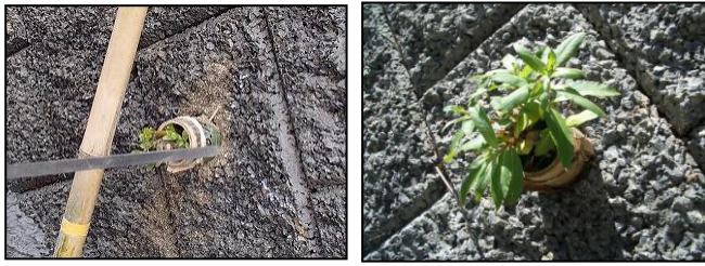
施工時の状況
