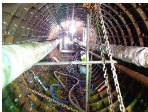
写真-3 セグメント組立状況
