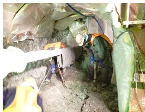
写真-2 横坑掘削状況
