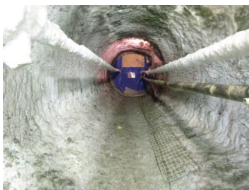
写真-3 横坑掘削完了
