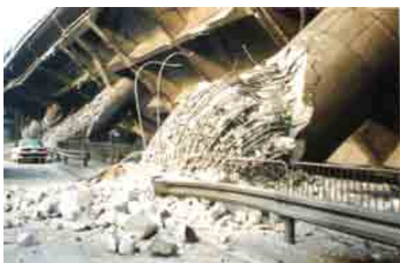
図-20 神 P140(東面) 20) (コンクリートの破壊面に沿い鉄筋のクビレが分布)
