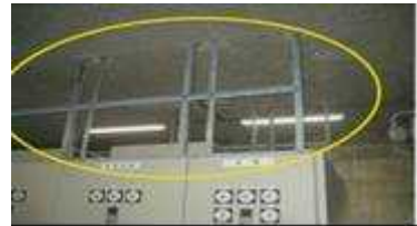
図-24 電気通信設備の転倒防止対策
