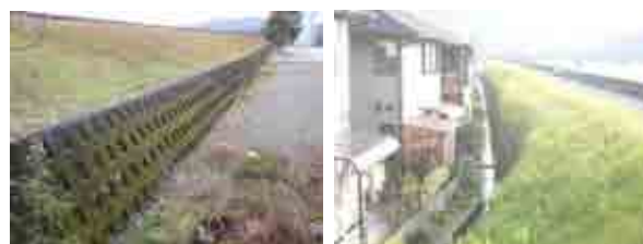
写真-1 補修事例1の状況
