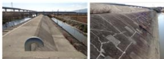
写真-6 洗堰の全景(左)と裏法コンクリート張(右)
