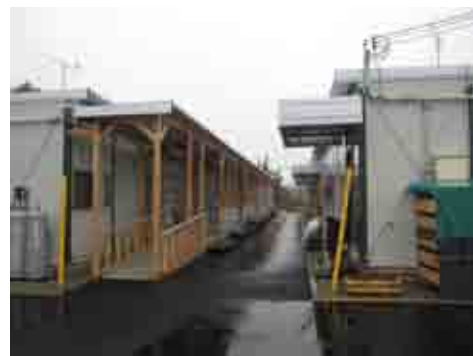
写真-4 渡り廊下の屋根設置(五條住宅)
