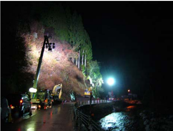
図-3 土砂崩れによる道路復旧の夜間照明支援
