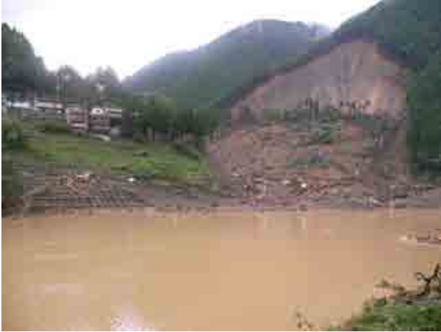
図-3 河道閉塞箇所（宇井地区）
