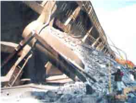
図-12 倒壊橋脚の代表例 神 P132(西面) 20)
