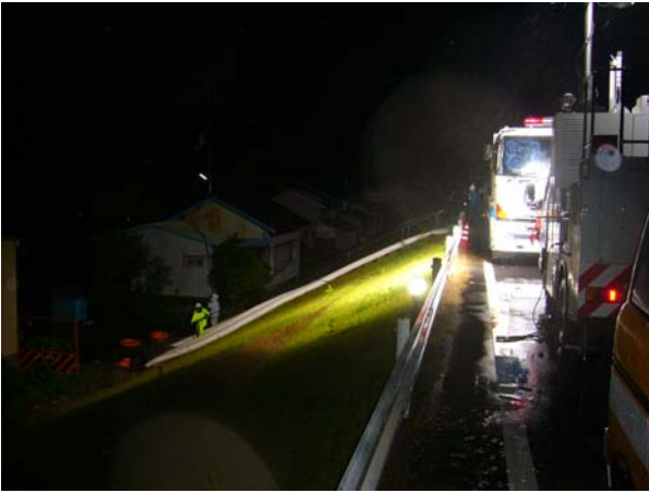
図-2 河川堤防上からの排水作業の夜間照明支援
