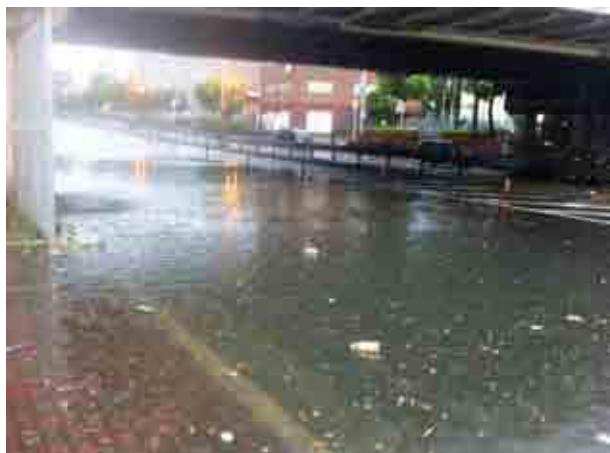
写真-3 国道26号大阪市内での冠水状況
