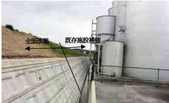
写真-9 全面改築箇所と既存施設補修箇所との比較状況
