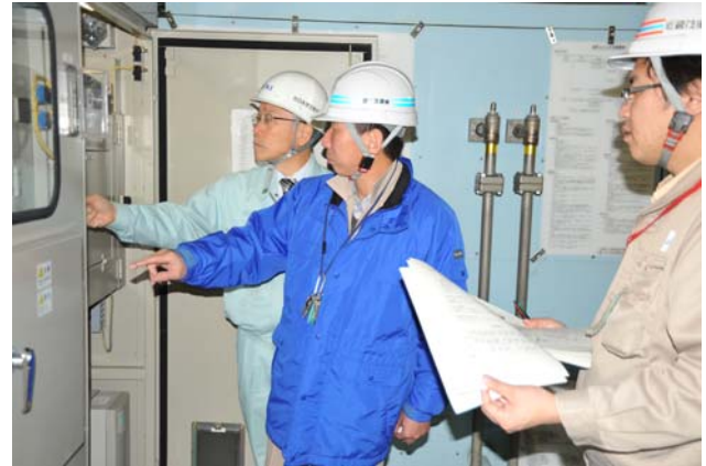
写真-2 手引きの試行状況(大滝ダム)
