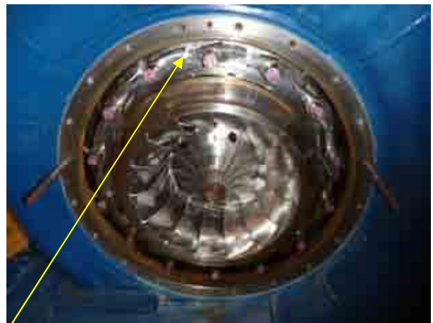
「ガイドベーン」の点検のためカバーを外したもの
