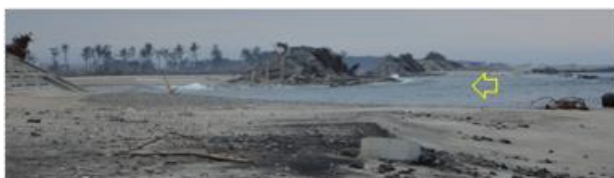
写真-1 決壊・流出(山元町坂元)：レベルS
