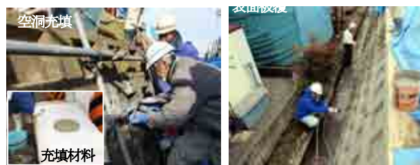
写真-3 施工状況
