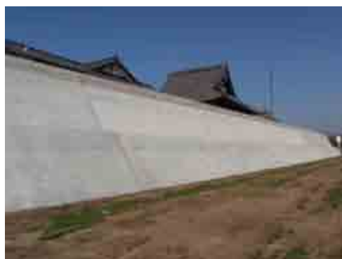
写真-8 補修箇所の施工後の状況
