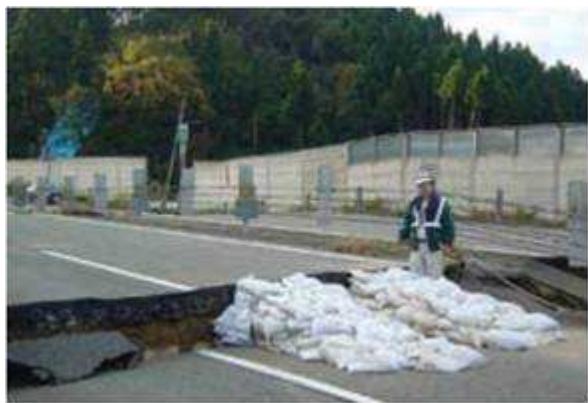
図-15 段差1箇所当りの土嚢量
