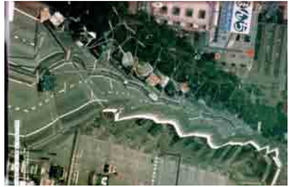
図-11 ピルツ橋倒壊区間の斜め航空写真 21) (白色の高欄線が極端に下がっている部分に着目)
