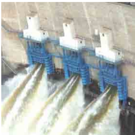
写真-1 ダム放流設備（天ヶ瀬ダム）
