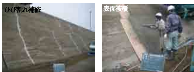
写真-7 施工状況
