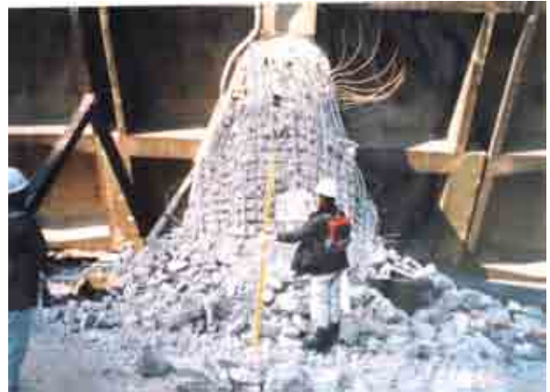
図-13 代表例 神 P132(南面) 20) (東西共ほぼ対称的な破壊形態、基部の外側へのふくらみなし)
