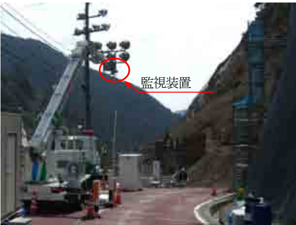
図-4 土砂崩れ現場の監視（昼夜）
