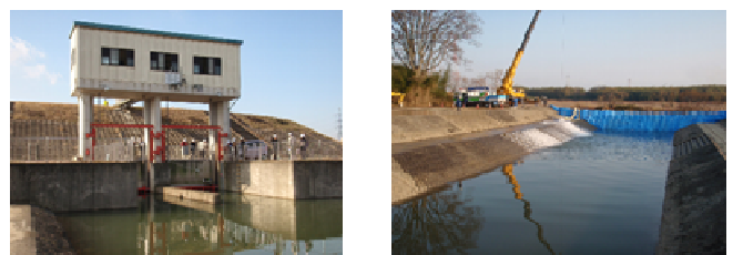
写真-2 樋門と水路末端の土嚢と注水状況
