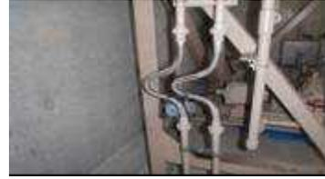
図-24 電気通信設備の転倒防止対策
