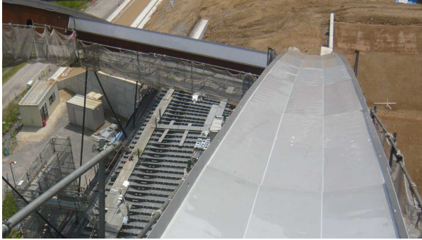
写真-5 落雪防止パネル 取付け後(アーチ上部)
