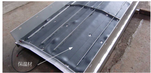
写真-3 落雪防止パネル 保温材(裏面)
