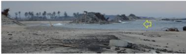
写真1 決壊・流出(山元町坂元)：レベルS
