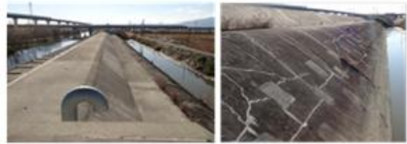
写真-6 洗堰の全景(左)と裏法コンクリート張(右)
